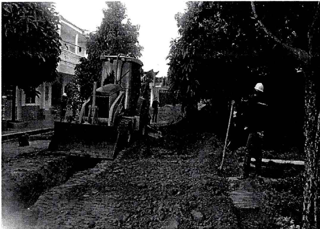
Excavación a maquina
