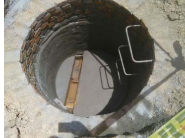
Construcción pozo de inspección
