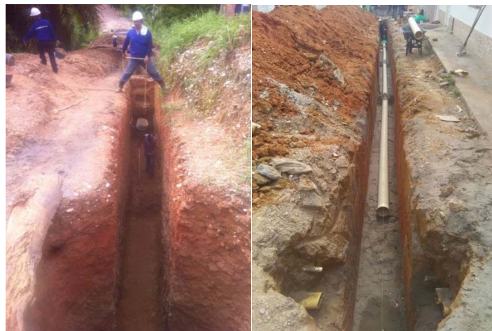
Excavación y colocación solado para la instalación de tubería
