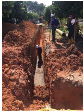
Colocación de solado para la instalación de la tubería
