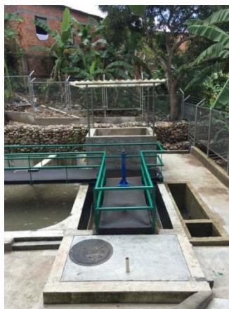
Pasarela y lecho de secado de lodos
