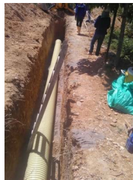
Instalación de tubería para aguas lluvias
