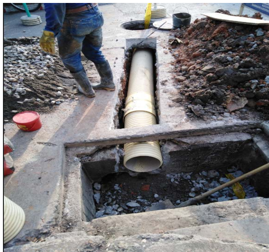
Reparación tramo de alcantarillado por obstrucción de res
