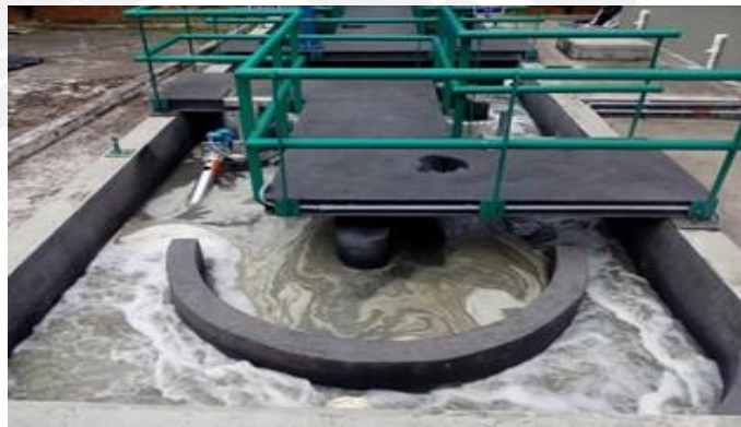
Operación zanjón de oxidación
