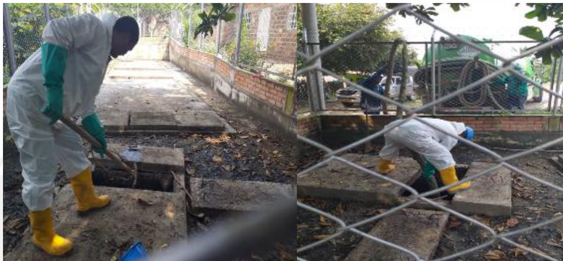
LLANITO I, (Limpieza de estructura cribado, Limpieza tanque desarenador, Limpieza de filtro anaerobio, Limpieza tanque sedimentador)
