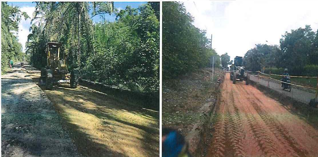
Figura 3. Conformación de la calzada existente
