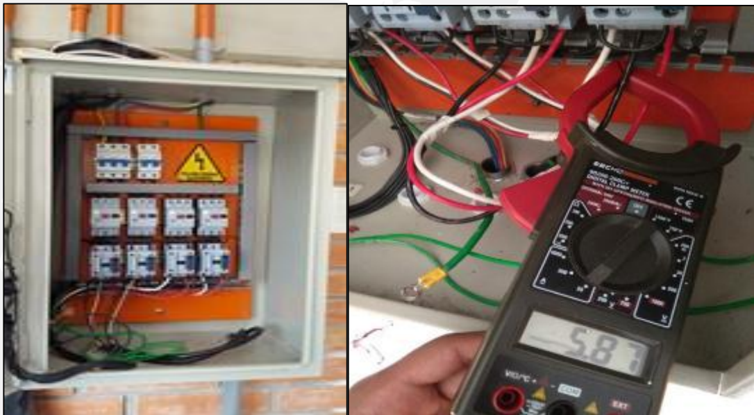
Verificación llegada de voltaje par ASOPRADOS
