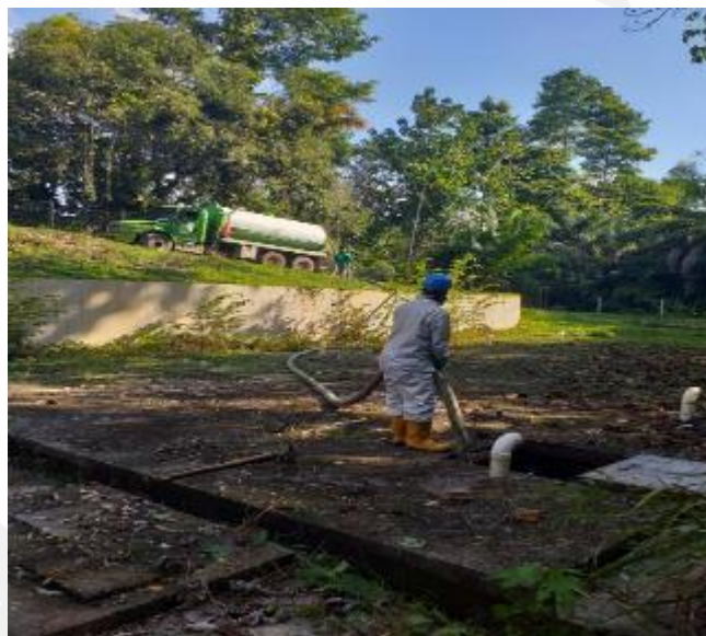
Laureles, (Limpieza de estructura cribado, Limpieza tanque desarenador, Limpieza de filtro anaerobio, Limpieza tanque sedimentador)
