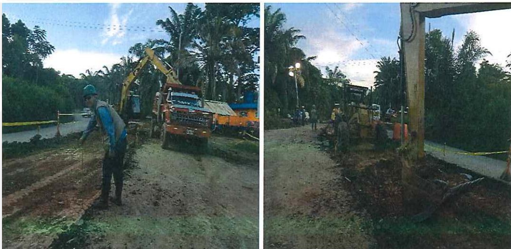
Figura 1. Excavación en material común de la explanación.
