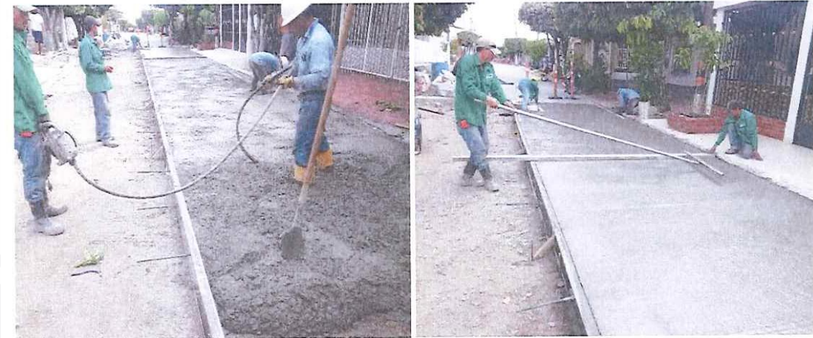
Figura 4. Suministro y colocación de concreto
