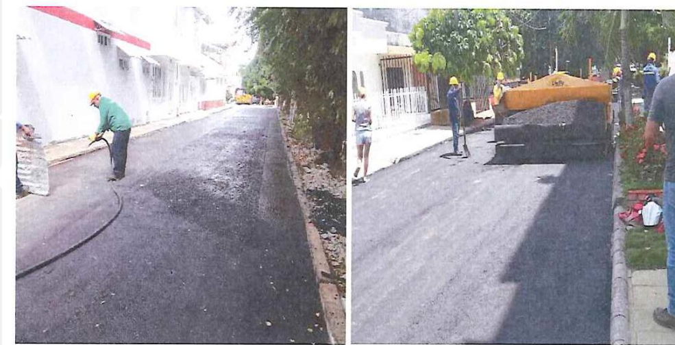
Figura 7. Mejoramiento capa asfáltica.
