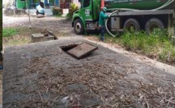
Limpieza manhol de llegada – ISLA DEL ZAPATO I
