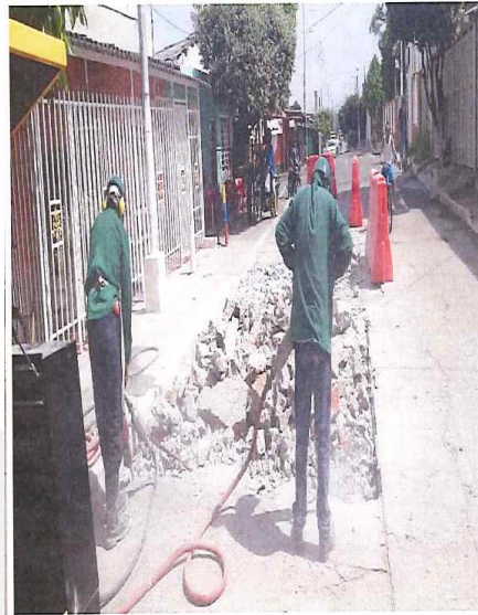
Figura 1. Demolición de pavimento rígido
