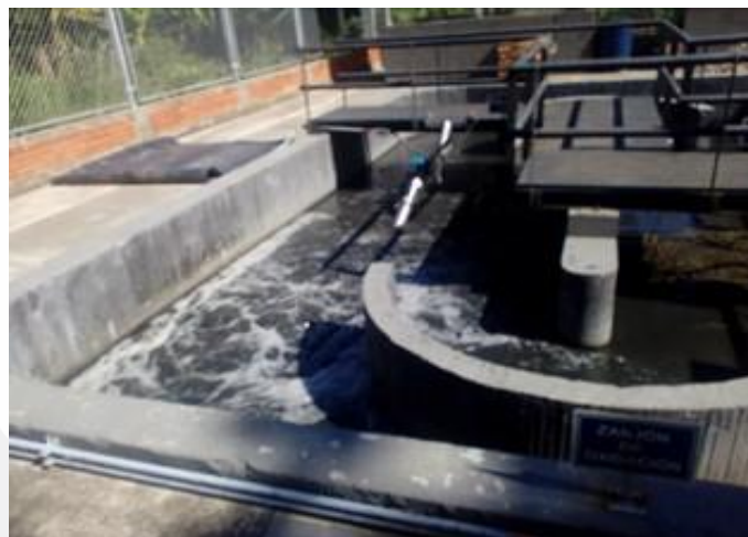
Operación zanjón de oxidación
