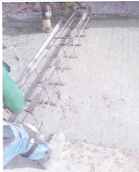
Figura 2. Canastilla para aceros de transferencia
