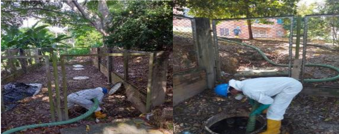
Limpieza de reactor compacto
