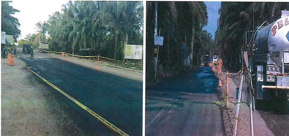
Figura 6. Riego de imprimación con emulsión asfáltica
