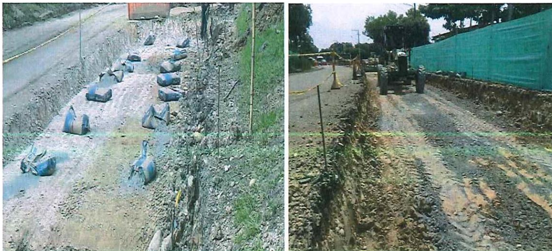
Figura 4. Subrasante estabilizada con cemento
