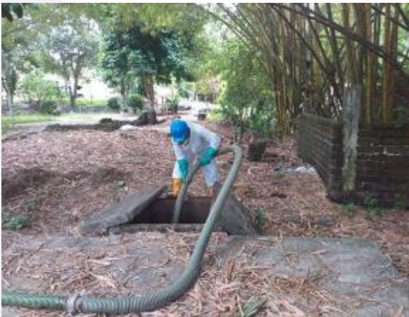
Limpieza desarenador – TAMARINDOS -
