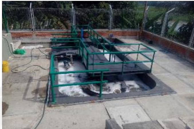
Operación zanjón de oxidación
