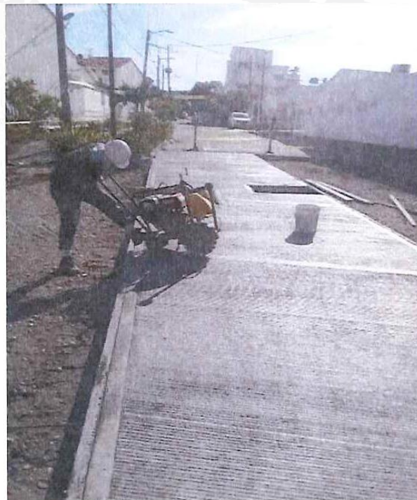
Figura 4. Suministro y colocación de concreto
