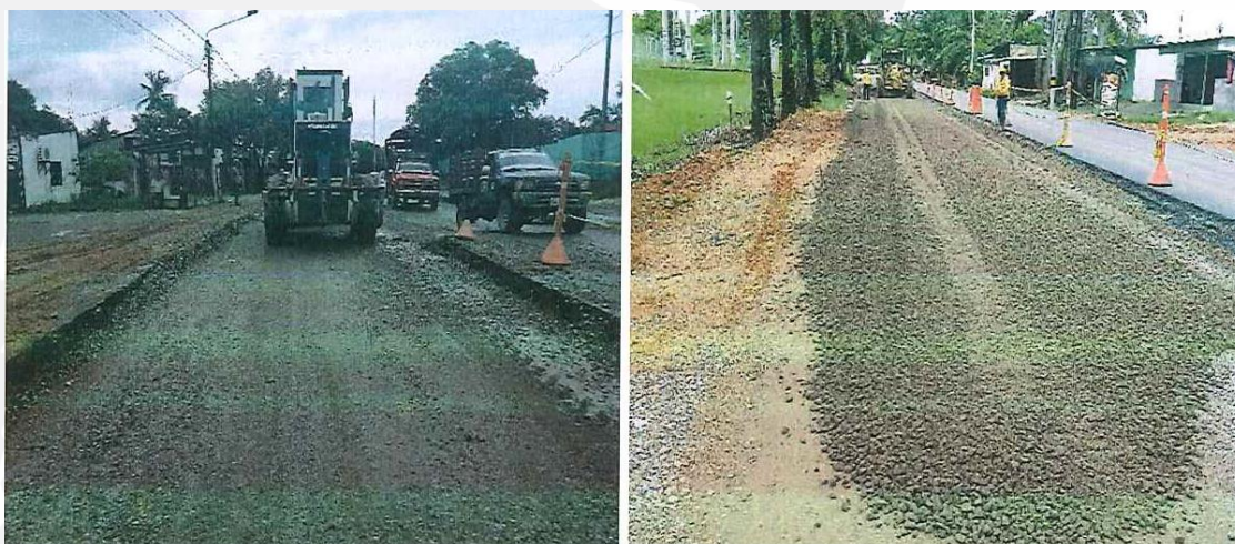
Figura 5. Extendido y compactación de base y subbase granular
