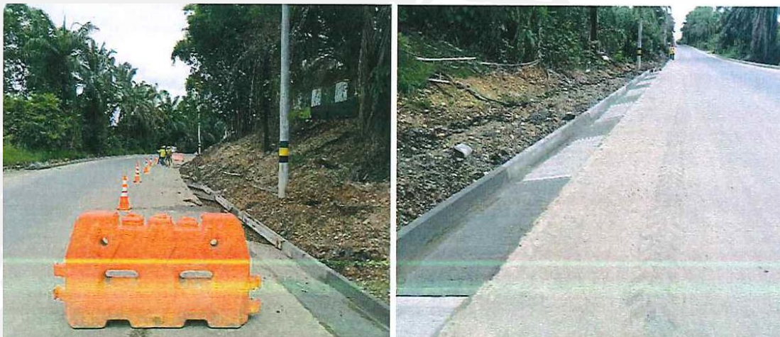
Figura 7. Cuenta de concreto fundida in situ
