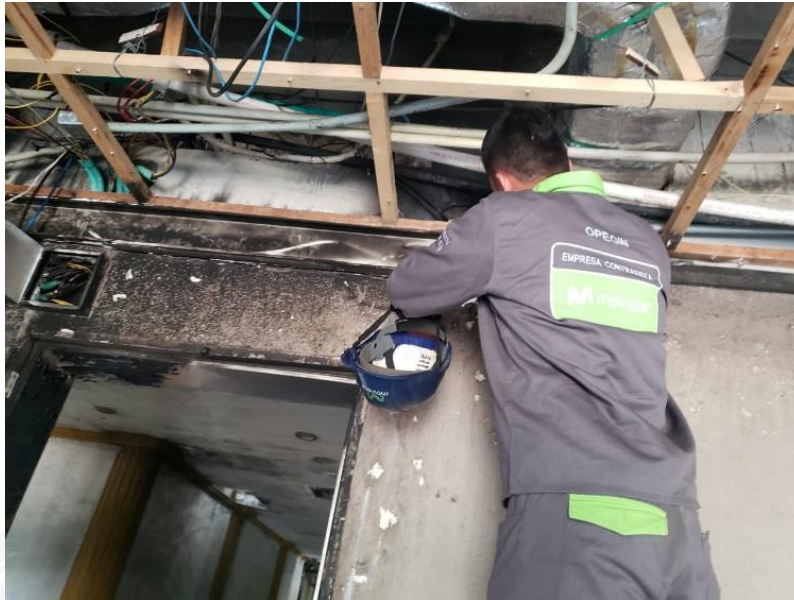
Reemplazo de la Fibra óptica del canal principal de telefonía PBX
